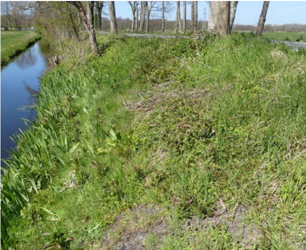
Figuur 114 Horstlaan, 23 april 2021. Schraal gedeelte met open zand tussen het gras.
