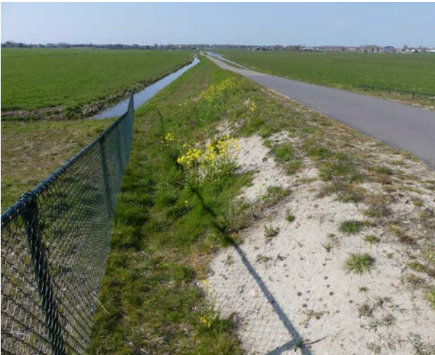
Figuur 66 Fietspad 90, 18 april 2021. Nieuwe, kale grond op het talud aan het begin van het fietspad.
