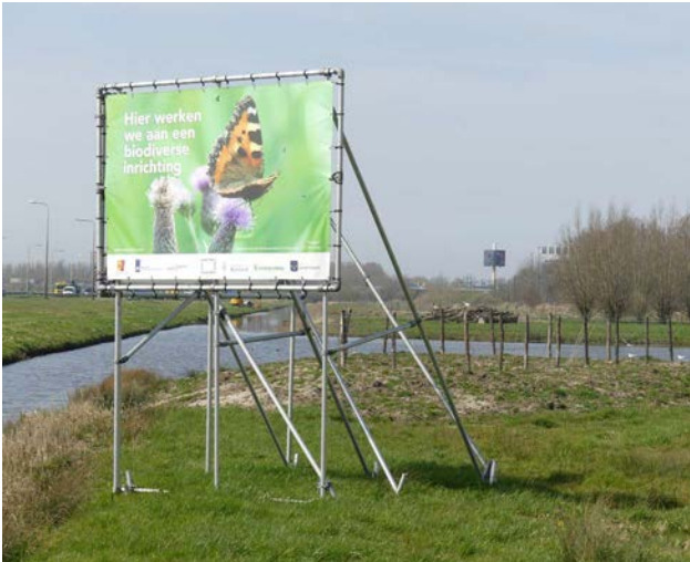
Figuur 47 Elfenbaan Vak 1, 31 maart 2021. In de winter van '20-'21 zijn grootschalige inrichtingsmaatregelen uitgevoerd.
